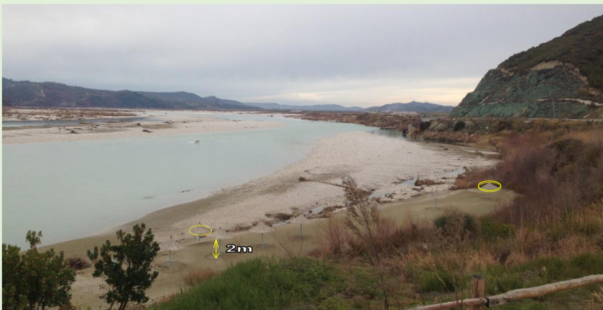
Figura Nr. 18 - Përmbytja datë: 2 dhjetor 2017 dhe situata pas përmbytjes datë: 12 janar 2018 në lumin Vjosë, zonën e Tepelenës. Foto : A. Hasimi.
